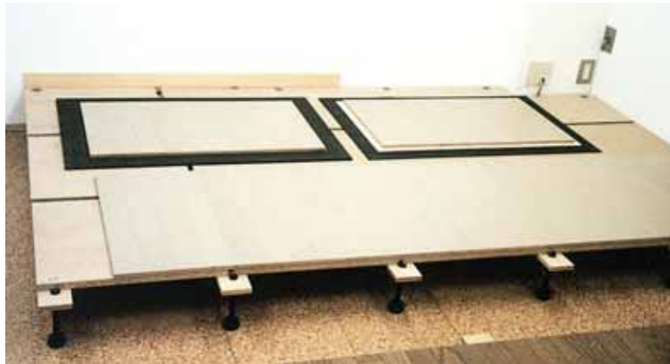
（置床の施工例）
